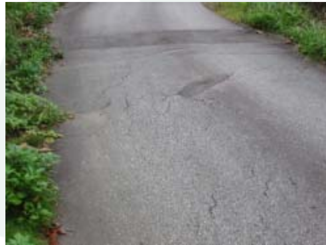
道路の亀裂発生状況
